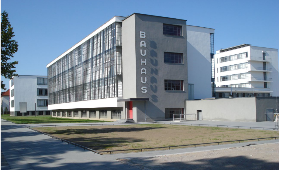
Bild 1. Ansicht des Hauptgebäudes (Süd/West)
